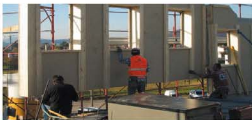
■ Un cantiere Wood Beton, prefabbricati misti legno-calcestruzzo
